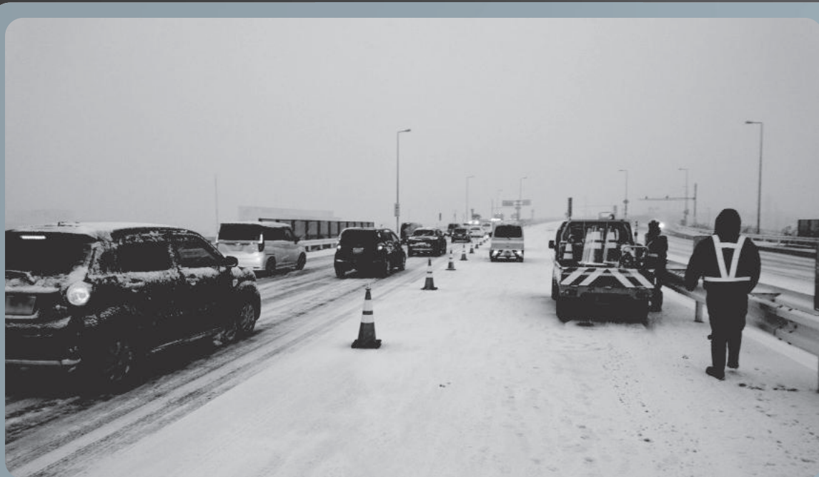
⑧ 津幡町舟橋JCT R5.1.24富山方面通行止め
